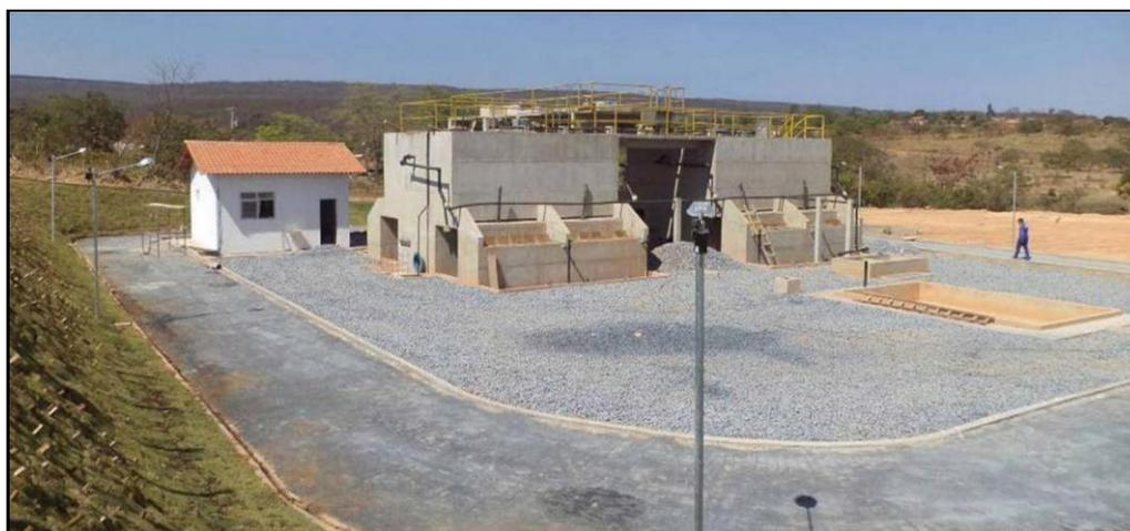
**Figura 3.6** – Vista de um sistema compacto composto por reator UASB + filtro percolador + cantador secundário.
