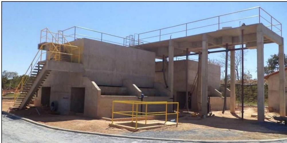
**Figura 3.4** – Vista de um sistema compacto composto por reator UASB + filtro percolador + cantador secundário.
