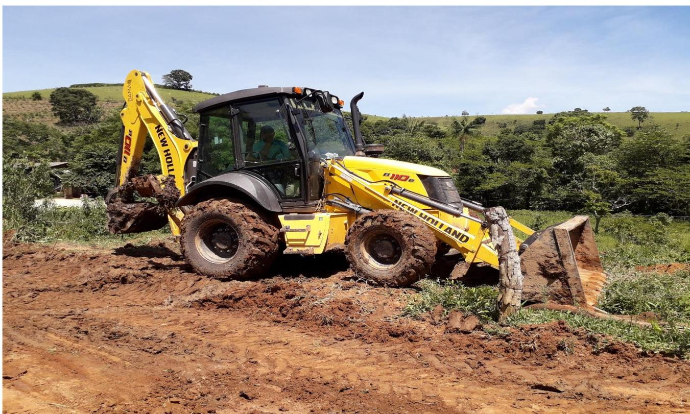
**ABERTURA DE CANAIS DE ESCOAMENTO SUPERFICIAL E SAÍDAS DE ÁGUA PARA DRENAGEM PLUVIAL DAS VIAS E CORREDORES RURAIS NO BAIRRO PORANTAVA.**
