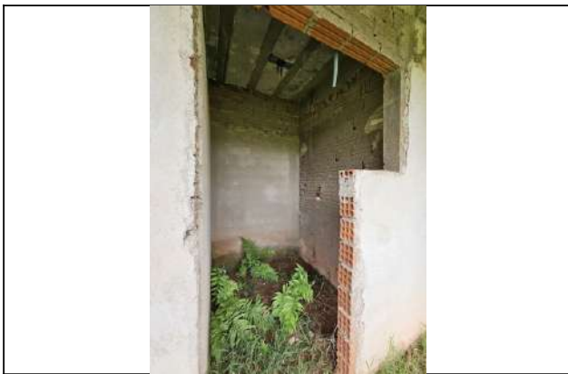
Foto 37. A sequência de fotos à partir desta de número 32, vê-se o interior dos blocos de serviço e pedagógico, os mesmos estão repletos de vegetação, de rebocos desfeitos e sem o piso. Cabe a empresa de reforma executar impermeabilização, contra pisos e reforço de laje.
