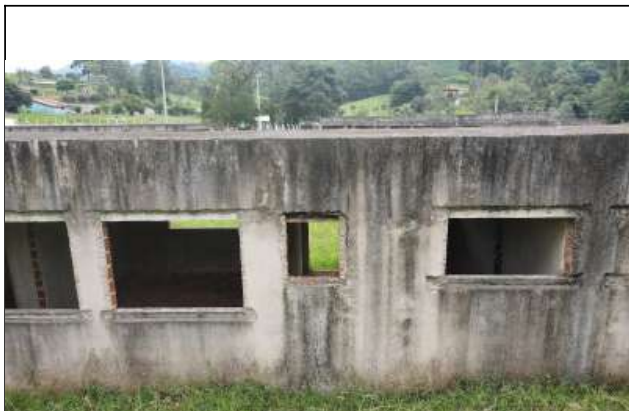
Foto 24. Bloco administrativo, alinhar todas as janelas, recompor as paredes quebradas e com vegetais. preparar paredes e vigas para receber recapeamento na laje.
