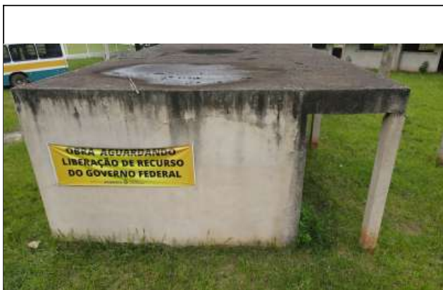
Foto 18. Bloco administrativo. Avaliação das paredes "in loco" as mesmas devem ser recuperadas, pois estão desgastadas com o tempo e às intempéries.
