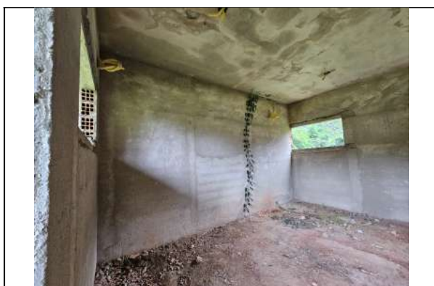
Foto 42. A sequência de fotos à partir desta de número 32, vê-se o interior dos blocos de serviço e pedagógico, os mesmos estão repletos de vegetação, de rebocos desfeitos e sem o piso. Cabe a empresa de reforma executar impermeabilização, contra pisos e reforço de laje.
