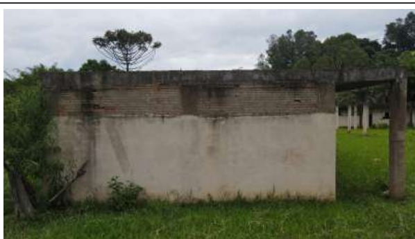
Foto 01. Bloco pedagógico - Criar pilar no centro da parede com estaca hélice contínua próximo ao baldrame
