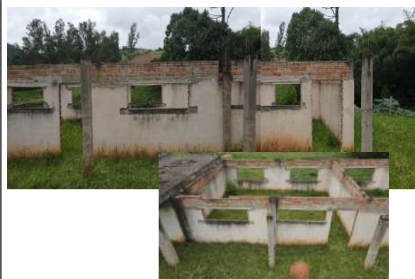
Foto 09. Bloco pedagógico - Nesta região necessita fazer as lajes e as mesmas apoiadas em vigas, ambas desenhadas em projetos apresentados. Também os pilares estão desenhado entre as janelas, pilares de reforço.
