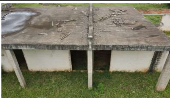
Foto 10. Bloco pedagógico - criar um pilar em cada lado das portas para sustentação da nova laje, demolir a laje existente. Avaliar no projeto estrutural o posicionamento das lajes e vigas.
