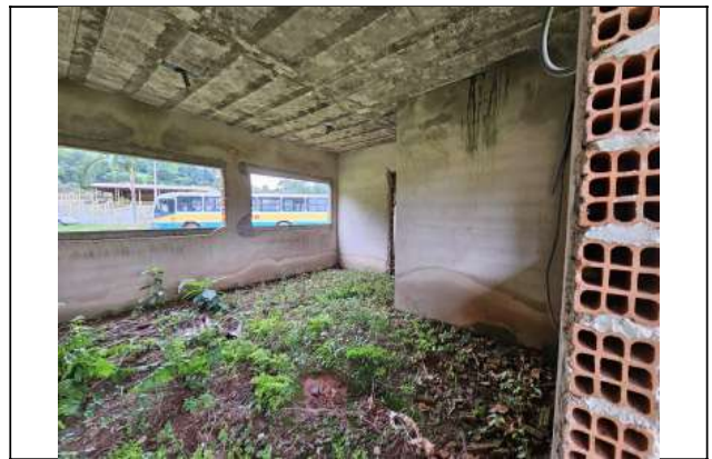
Foto 38. A sequência de fotos à partir desta de número 32, vê-se o interior dos blocos de serviço e pedagógico, os mesmos estão repletos de vegetação, de rebocos desfeitos e sem o piso. Cabe a empresa de reforma executar impermeabilização, contra pisos e reforço de laje.
