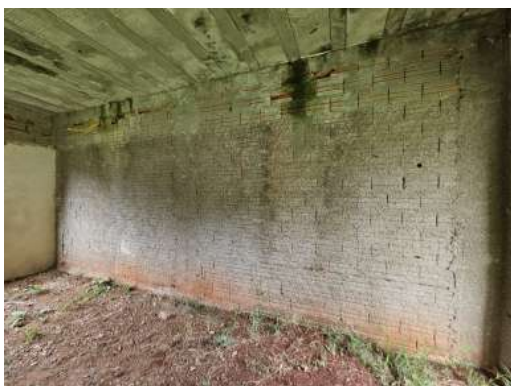
Foto 13. Bloco pedagógico - Paredes internas que devem ser recuperadas e com a criação de um pilar no centro e na sua parte superior executar uma viga transversal.
