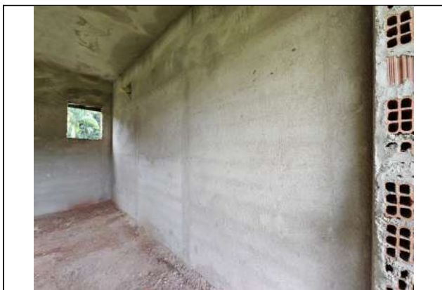
Foto 43. A sequência de fotos à partir desta de número 32, vê-se o interior dos blocos de serviço e pedagógico, os mesmos estão repletos de vegetação, de rebocos desfeitos e sem o piso. Cabe a empresa de reforma executar impermeabilização, contra pisos e reforço de laje.
