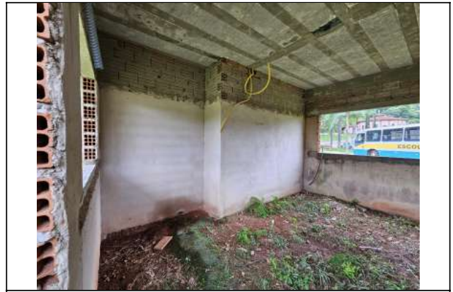
Foto 36. A sequência de fotos à partir desta de número 32, vê-se o interior dos blocos de serviço e pedagógico, os mesmos estão repletos de vegetação, de rebocos desfeitos e sem o piso. Cabe a empresa de reforma executar impermeabilização, contra pisos e reforço de laje.
