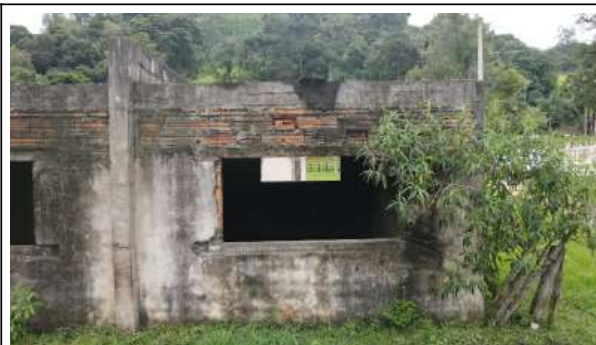
Foto 02 Bloco pedagógico - criar verga sobre a janela verificar nível da janela
