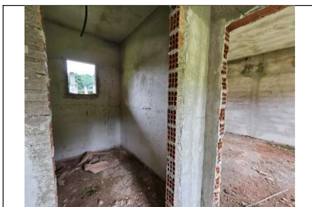
Foto 46. A sequência de fotos à partir desta de número 32, vê-se o interior dos blocos de serviço e pedagógico, os mesmos estão repletos de vegetação, de rebocos desfeitos e sem o piso. Cabe a empresa de reforma executar impermeabilização, contra pisos e reforço de laje.
