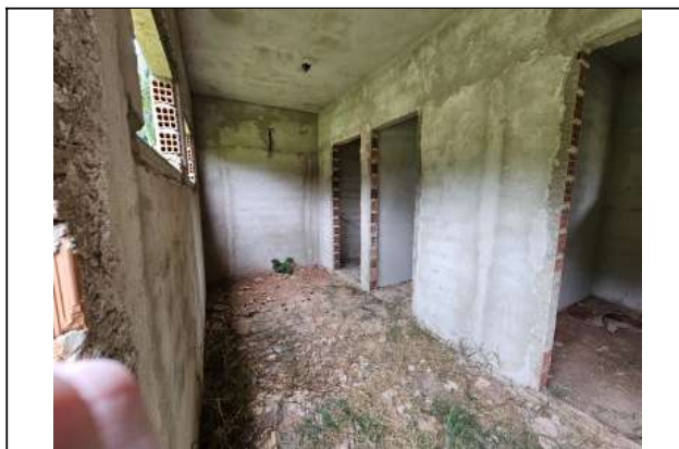
Foto 44. A sequência de fotos à partir desta de número 32, vê-se o interior dos blocos de serviço e pedagógico, os mesmos estão repletos de vegetação, de rebocos desfeitos e sem o piso. Cabe a empresa de reforma executar impermeabilização, contra pisos e reforço de laje.
