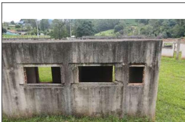
Foto 23. Bloco administrativo, alinhar todas as janelas, recompor as paredes quebradas e com vegetais. preparar paredes e vigas para receber recapeamento na laje.
