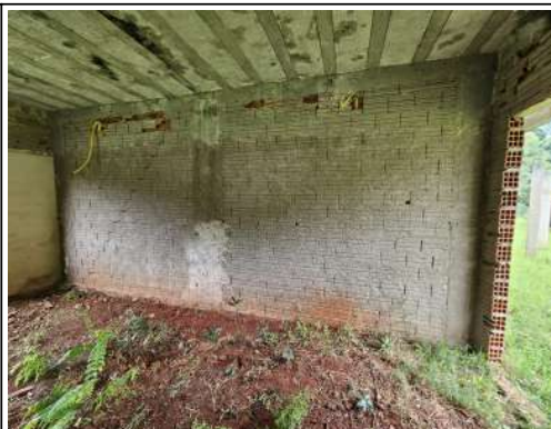
Foto 14. Bloco pedagógico - Paredes internas que devem ser recuperadas e com a criação de um pilar no centro e na sua parte superior executar uma viga transversal.
