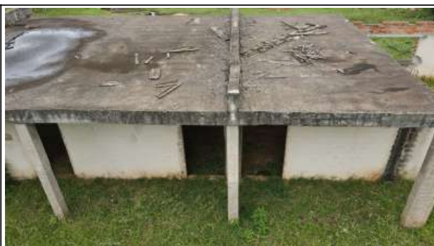
Foto 17-2. Bloco pedagógico - Vista superior do bloco pedagógico com detalhes das lajes a serem demolidas e o cuidado com as vigas sobre as mesmas, elas não existiam no projeto original.
