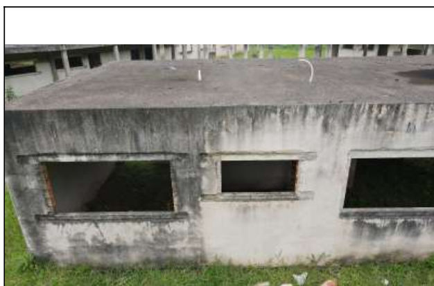
Foto 21. Bloco administrativo, alinhar todas as janelas, recompor as paredes quebradas e com vegetais. preparar paredes e vigas para receber recapeamento na laje.
