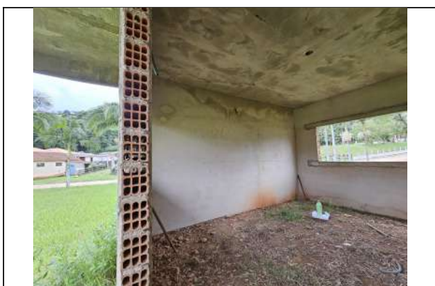
Foto 41. A sequência de fotos à partir desta de número 32, vê-se o interior dos blocos de serviço e pedagógico, os mesmos estão repletos de vegetação, de rebocos desfeitos e sem o piso. Cabe a empresa de reforma executar impermeabilização, contra pisos e reforço de laje.
