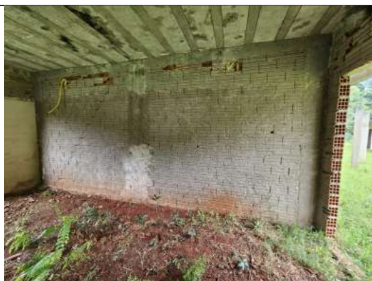
Foto 34. Vista interna - A sequência de fotos à partir desta de número 32, vê-se o interior dos blocos de serviço e pedagógico, os mesmos estão repletos de vegetação, de rebocos desfeitos e sem o piso. Cabe a empresa de reforma executar impermeabilização, contra pisos e reforço de laje.
