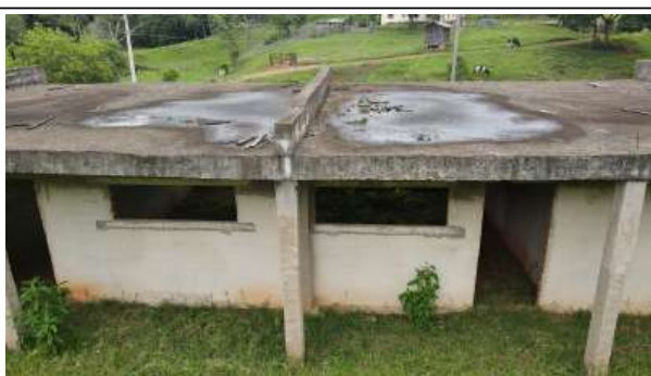
Foto 12. Bloco pedagógico - Demolir a laje criar o pilar embutido no canto da parede e entre as janelas
