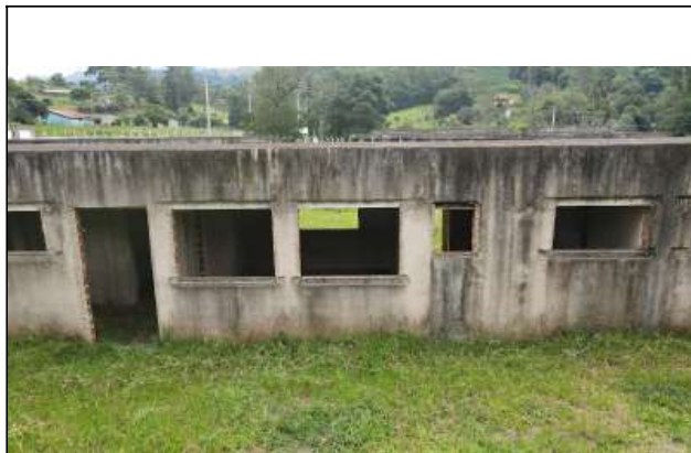
Foto 25. Bloco administrativo, alinhar todas as janelas, recompor as paredes quebradas e com vegetais. preparar paredes e vigas para receber recapeamento na laje.
