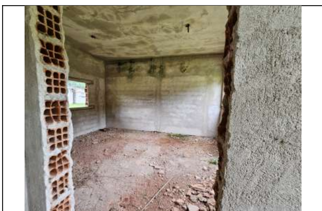
Foto 45. A sequência de fotos à partir desta de número 32, vê-se o interior dos blocos de serviço e pedagógico, os mesmos estão repletos de vegetação, de rebocos desfeitos e sem o piso. Cabe a empresa de reforma executar impermeabilização, contra pisos e reforço de laje.
