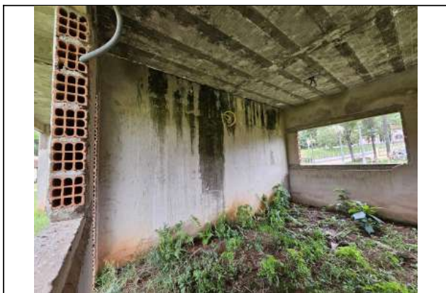
Foto 39. A sequência de fotos à partir desta de número 32, vê-se o interior dos blocos de serviço e pedagógico, os mesmos estão repletos de vegetação, de rebocos desfeitos e sem o piso. Cabe a empresa de reforma executar impermeabilização, contra pisos e reforço de laje.
