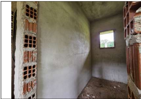
Foto 47. A sequência de fotos à partir desta de número 32, vê-se o interior dos blocos de serviço e pedagógico, os mesmos estão repletos de vegetação, de rebocos desfeitos e sem o piso. Cabe a empresa de reforma executar impermeabilização, contra pisos e reforço de laje.
