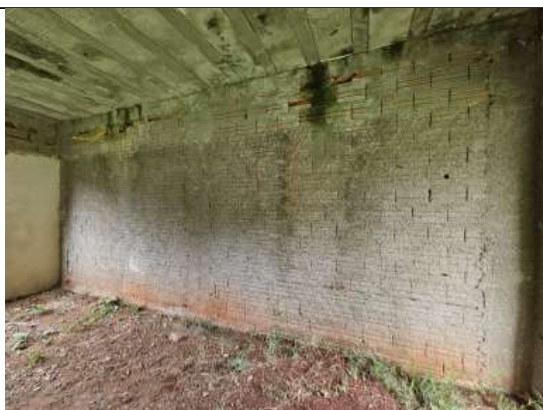
Foto 33. A sequência de fotos à partir desta de número 32, vê-se o interior dos blocos de serviço e pedagógico, os mesmos estão repletos de vegetação, de rebocos desfeitos e sem o piso. Cabe a empresa de reforma executar impermeabilização, contra pisos e reforço de laje.
