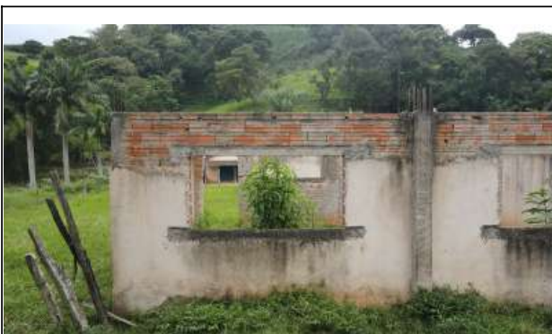
Foto 06A. Bloco pedagógico - Bloco pedagógico - Criar fundação na região onde há pilar para fora (lado direito) e fundação e pilar entre as janelas com estaca hélice contínua, Trocar vergas sobre as janelas, preparar vigamento sobre as paredes apoiados nos pilares e com as lajes engastadas.
