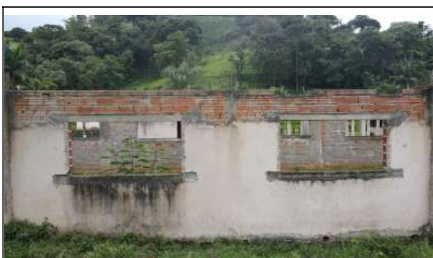
Foto 06. Bloco pedagógico - Criar fundação na região onde há pilar para fora (lado direito) e fundação e pilar entre as janelas com estaca hélice contínua, Trocar vergas sobre as janelas, preparar vigamento sobre as paredes apoiados nos pilares e com as lajes engastadas.
