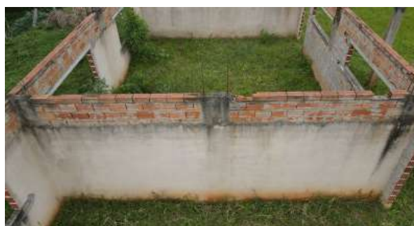
Foto 16. Bloco pedagógico - Paredes internas que devem ser recuperadas e com a criação de um pilar no centro e na sua parte superior executar uma viga transversal.
