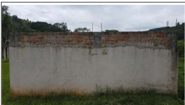
Foto 07. Bloco pedagógico - Criar pilar no centro da parede com estaca hélice contínua próximo ao baldrame
