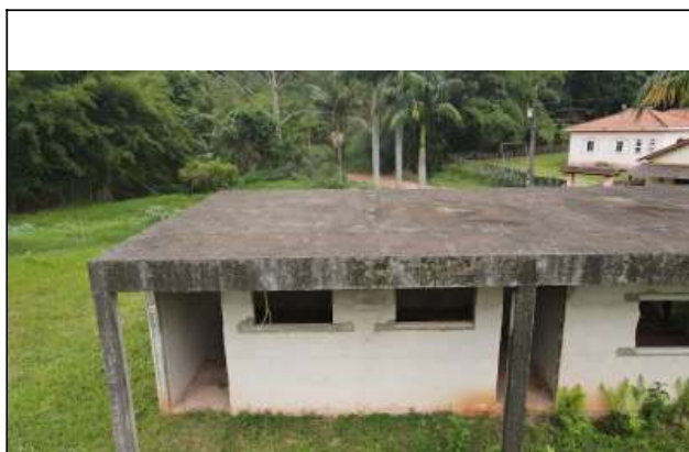
Foto 30. Bloco administrativo, alinhar todas as janelas, recompor as paredes quebradas e com vegetais. preparar paredes e vigas para receber recapeamento na laje.
