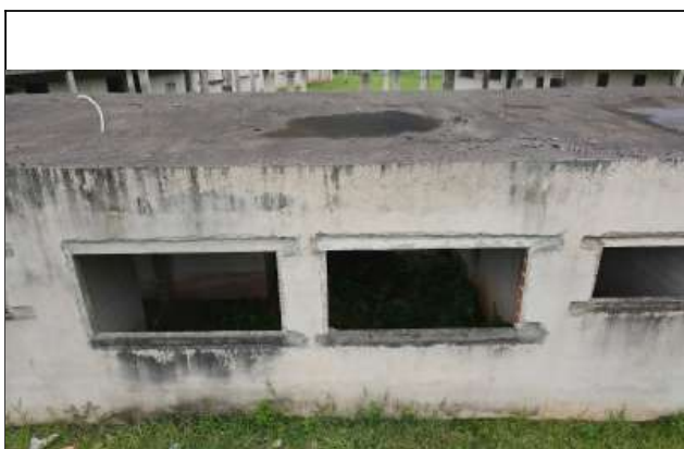
Foto 20. Bloco administrativo, alinhar todas as janelas, recompor as paredes quebradas e com vegetais. preparar paredes e vigas para receber recapeamento na laje.
