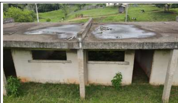
Foto 11. Bloco pedagógico - Reforçar ou criar um pilar entre as duas janelas. Conforme projeto. Demolir as lajes.
