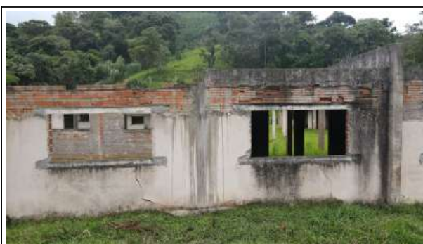
Foto 05. Bloco pedagógico - Criar fundação na região onde há pilar para fora (lado direito) e fundação e pilar entre as janelas com estaca hélice contínua, trocar vergas sobre as janelas, observa-se que a laje vai até a metade do cômodo. fazer junta fria entre as lajes
