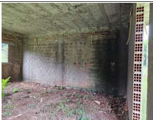
Foto 15. Bloco pedagógico - Paredes internas que devem ser recuperadas e com a criação de um pilar no centro e na sua parte superior executar uma viga transversal.
