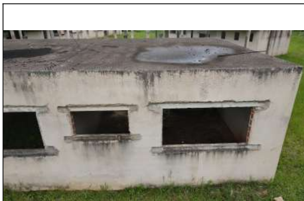
Foto 19. Bloco administrativo, alinhar todas as janelas, recompor as paredes quebradas e com vegetais. preparar paredes e vigas para receber recapeamento na laje.
