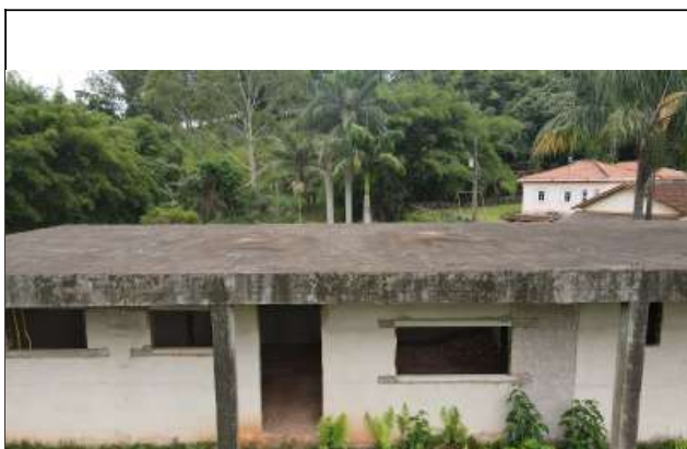
Foto 29. Bloco administrativo, alinhar todas as janelas, recompor as paredes quebradas e com vegetais. preparar paredes e vigas para receber recapeamento na laje.
