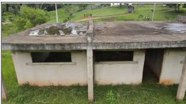
Foto 12A. Bloco pedagógico - Além de demolir as lajes criar vergas e contravergas em todas as janelas.
