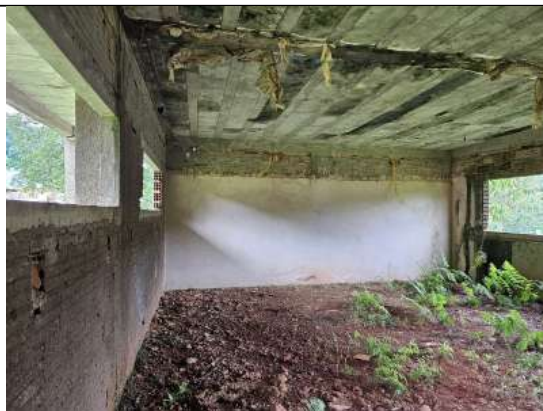
Foto 32. A sequência de fotos à partir desta de número 32, vê-se o interior dos blocos de serviço e pedagógico, os mesmos estão repletos de vegetação, de rebocos desfeitos e sem o piso. Cabe a empresa de reforma executar impermeabilização, contra pisos e reforço de laje.
