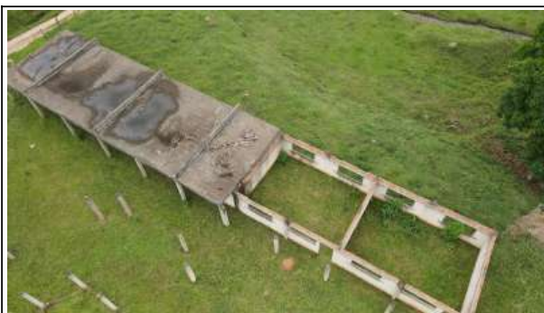
Foto 17-1. Bloco pedagógico - Vista superior do bloco pedagógico com detalhes das lajes a serem demolidas e o cuidado com as vigas sobre as mesmas, elas não existiam no projeto original.
