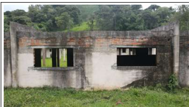
Foto 04. Bloco pedagógico - Criar fundação na região onde há pilar para fora (lado direito) e fundação e pilar entre as janelas com estaca hélice contínua, reforçar verga sobre as janelas.
