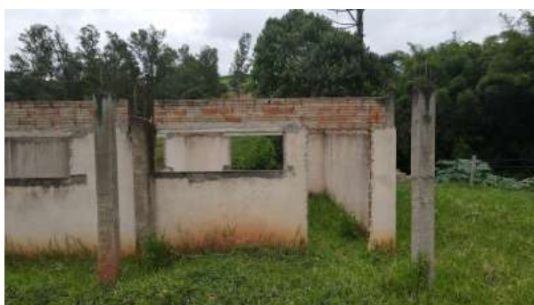
Foto 08A. Bloco pedagógico - Cria novo apoio nos pilares do canto e na direita desta foto. Seguindo os projetos apresentados.
