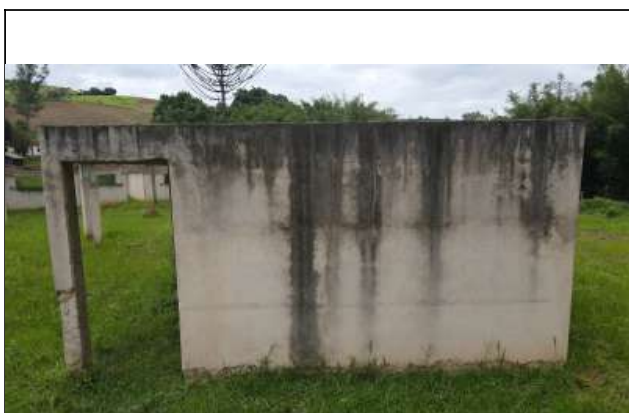
Foto 27. Bloco de serviço, alinhar todas as janelas, recompor as paredes quebradas e com vegetais. preparar paredes e vigas para receber recapeamento na laje.
