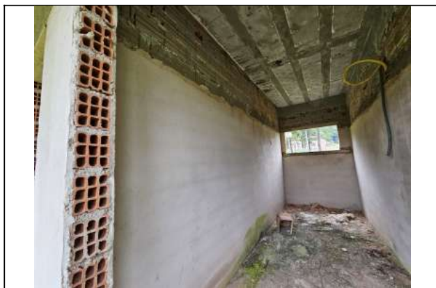
Foto 40. A sequência de fotos à partir desta de número 32, vê-se o interior dos blocos de serviço e pedagógico, os mesmos estão repletos de vegetação, de rebocos desfeitos e sem o piso. Cabe a empresa de reforma executar impermeabilização, contra pisos e reforço de laje.
