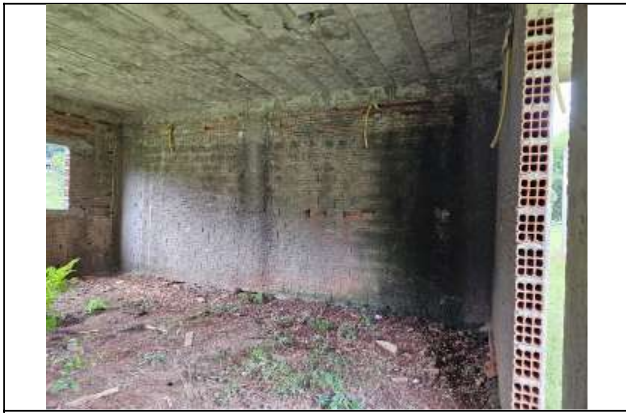
Foto 35. A sequência de fotos à partir desta de número 32, vê-se o interior dos blocos de serviço e pedagógico, os mesmos estão repletos de vegetação, de rebocos desfeitos e sem o piso. Cabe a empresa de reforma executar impermeabilização, contra pisos e reforço de laje.
