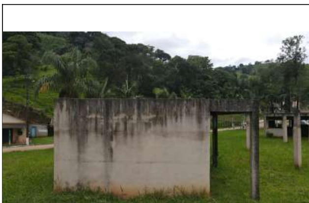
Foto 22. Bloco administrativo, alinhar todas as janelas, recompor as paredes quebradas e com vegetais. preparar paredes e vigas para receber recapeamento na laje.
